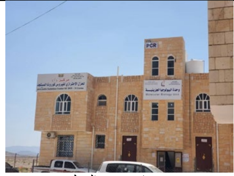
مباني وحدة العزل
