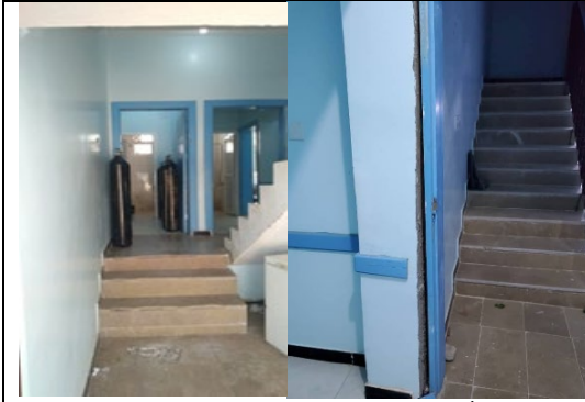
بلاط الأرضيات تالف مع عدم وجود درابزين
