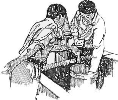
الشكل ٧-٢ غمر البئر بالمياه عن طريق دفق المياه الغزيرة داخله
